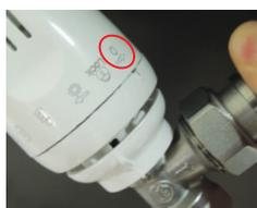
• en position ← le réglage est limité entre la position actuelle et la position 0 (shut-off) .
