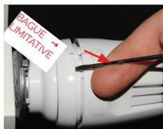
1) Tourner le volant dans la position que l'on souhaite bloquer/partialiser et décrocher la bague de limitation, en s'aidant d'un tournevis.
