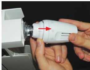
**2)** Tirez sur la bague Clip Clap vers le bulbe.
