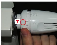
2) Tourner la bague limitative et la raccrocher, en prenant comme repère l'encoche indicatrice "T" (voir figure), au niveau d'une des 3 icônes présentes à l'arrière du volant :
