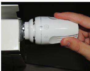
**4)** La tête est maintenant fixée au robinet et peut être placée sur la position désirée
